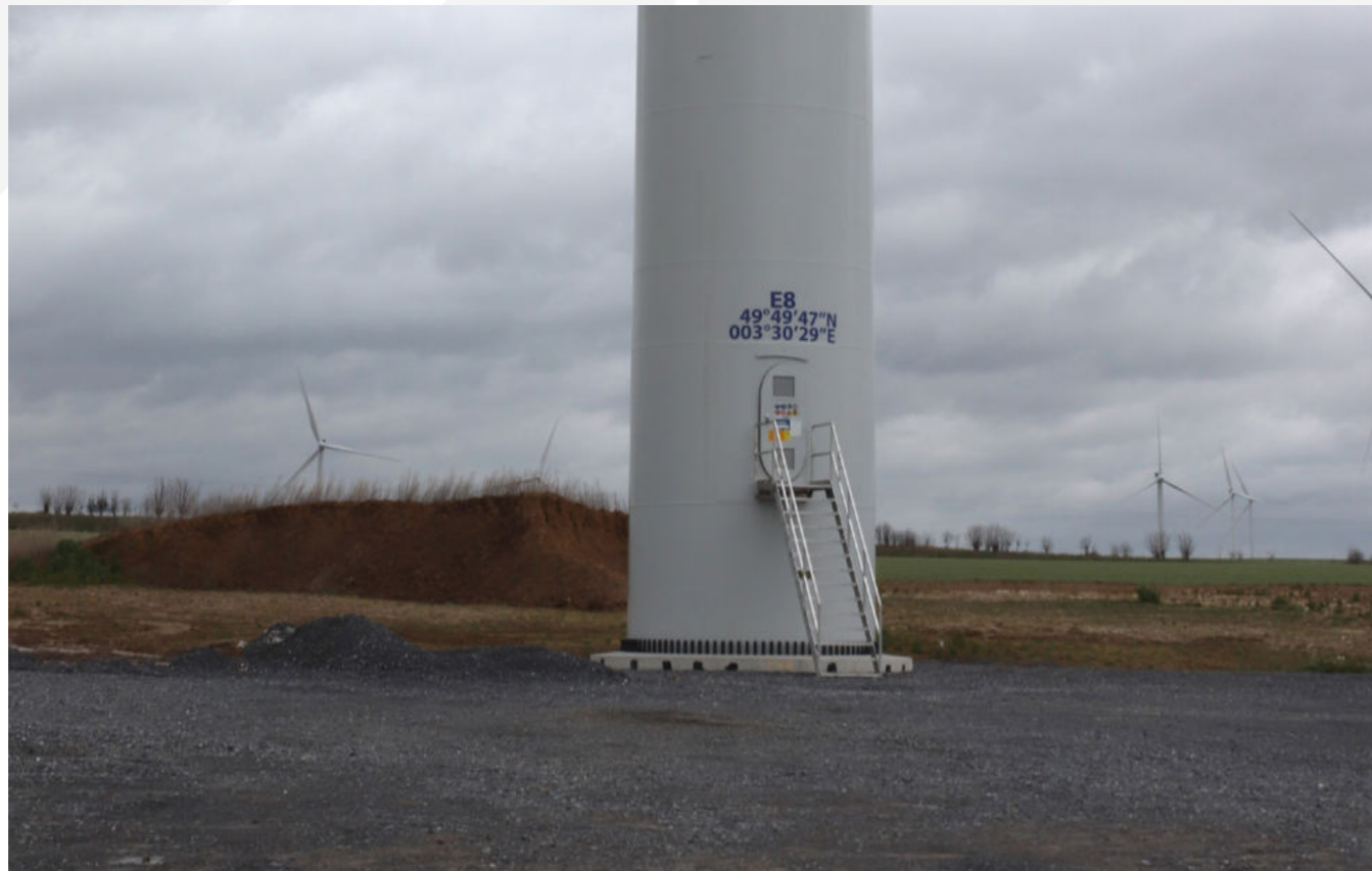
Image du chantier du parc du Mont Hussard
